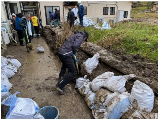
土砂を土嚢袋に入れ土留め
