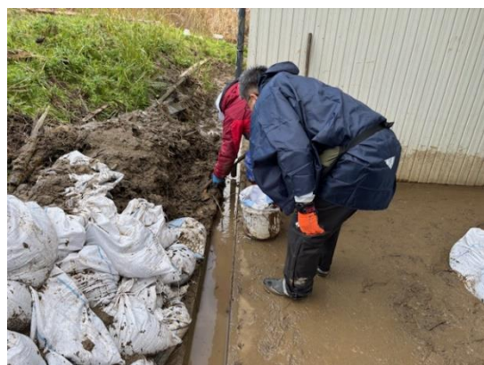
側溝が土砂で埋まっている
